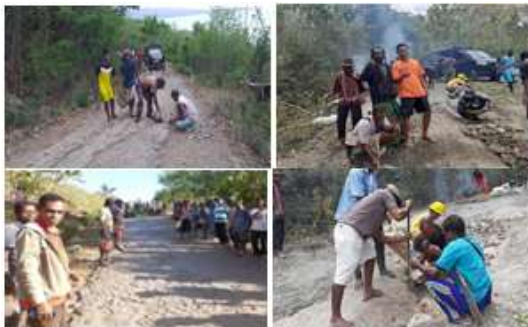
Gambar 1. Proses Pengecoran Jalan
