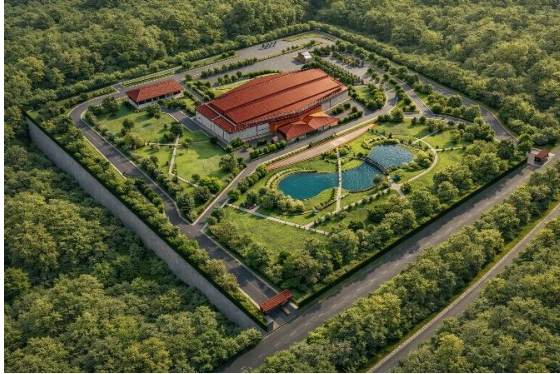
Gambar 4. Tampilan Bangunan Sumber Gambar: (Analisa Penulis, 2025)
